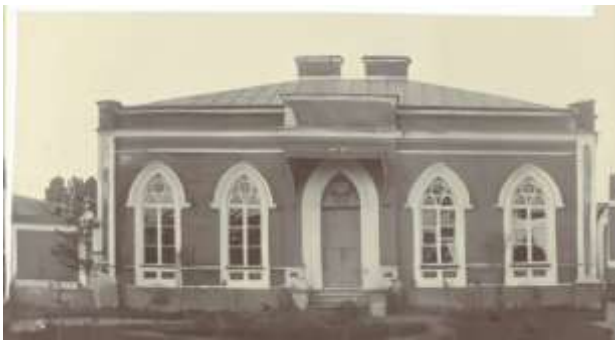
Станция в Волнярово
