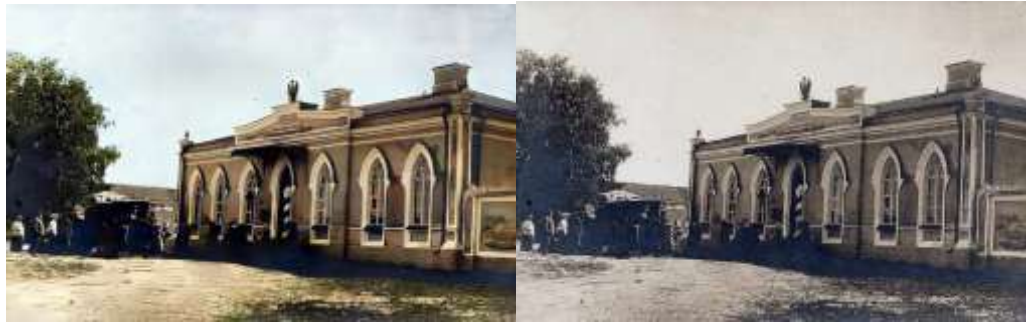
Станция в Опочке (относится ко 2-му разряду).
