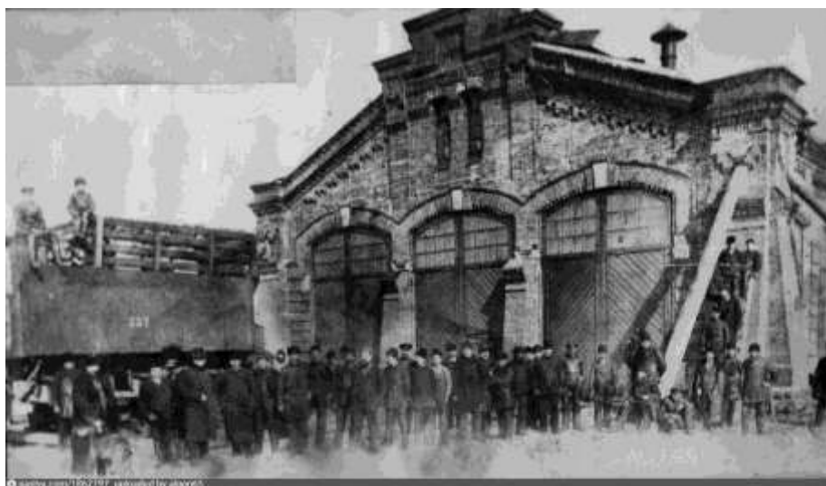
Рис. 168. Паровозное здание на станции Боготол 96
