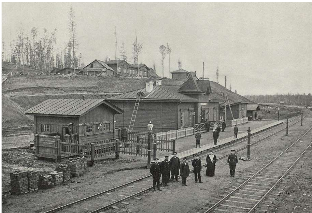
Рис. 20. Пример станции 4-го класса. Станция Кременчуг. 48
