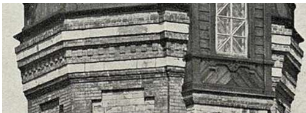
Рис. 138. Фрагмент фото здания на станции Ояш.
