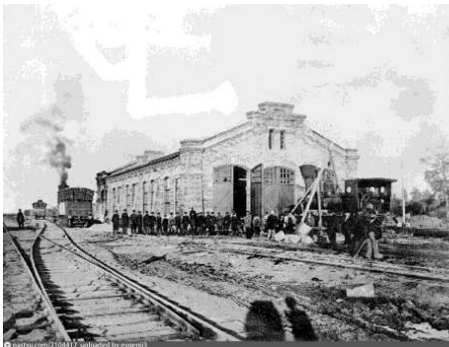
Рис. 167. Паровозное здание на станции Боготол 95
