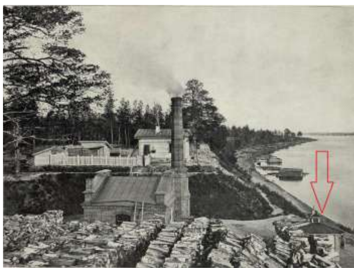
Рис. 100. Водоприемное здание на станции Обь. 76
