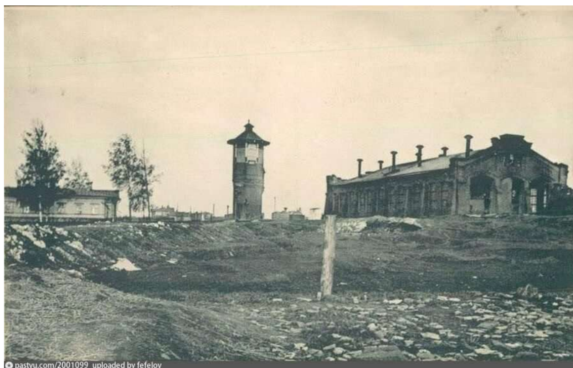
Рис 94 . 166. Паровозное здание на станции Тайшет
